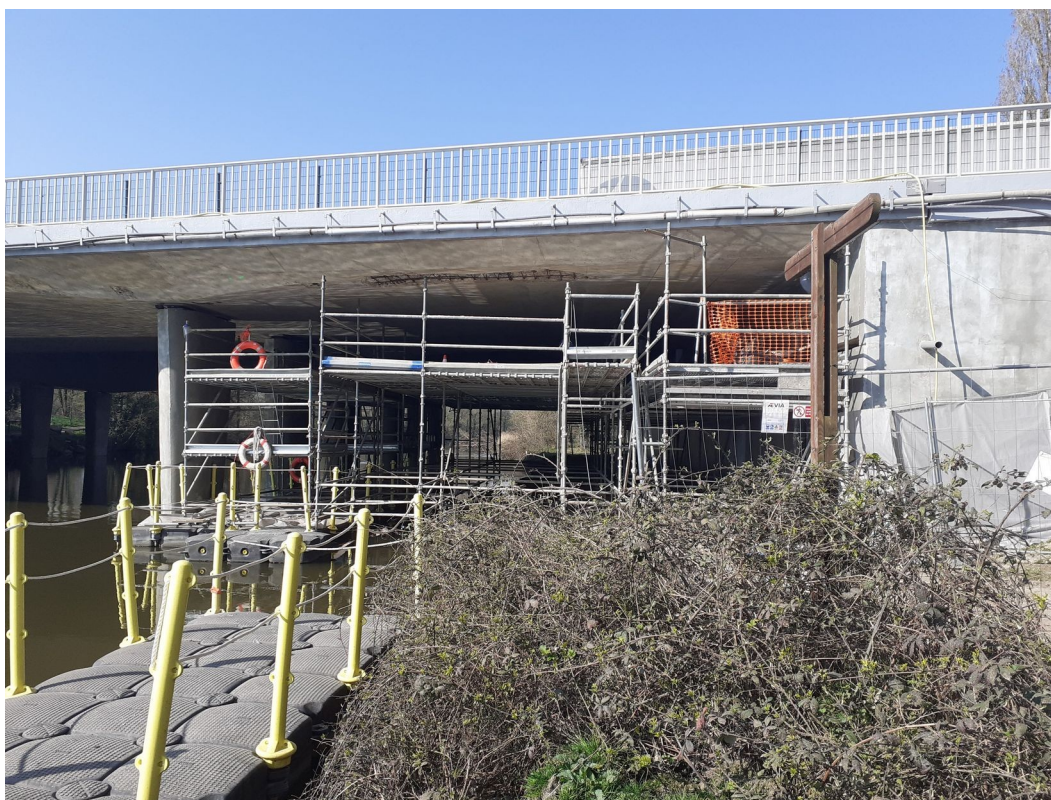
Figure 1: Photo de l'échafaudage présent sous l'ouvrage pour réaliser les travaux
